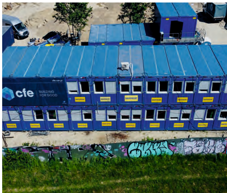
Budowa Designer Outlet Kraków
